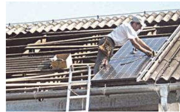
Montage der neuen Anlagen. KK
